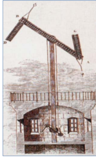
Telégrafo óptico de Claude Chappe instalado sobre el tejado del Louvre
