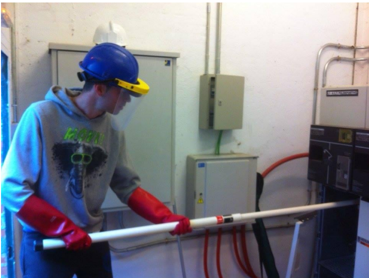
AULA DE CENTROS DE TRANSFORMACIÓN
