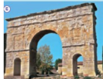
Acueducto de Segovia. Arco de Medinaceli (Soria).
