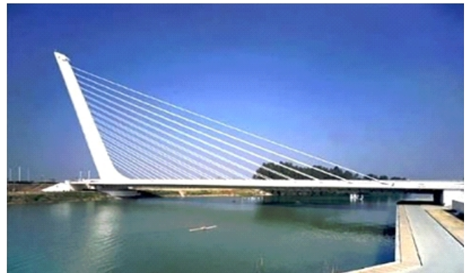
Puente atirantado, El Alamillo, Sevilla.
