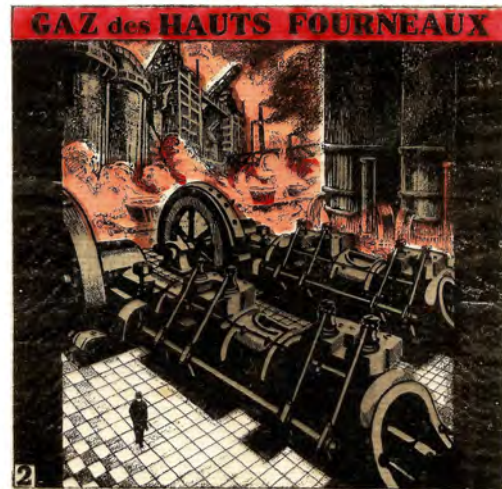
2.- GAZ des HAUTS FOURNEAUX
