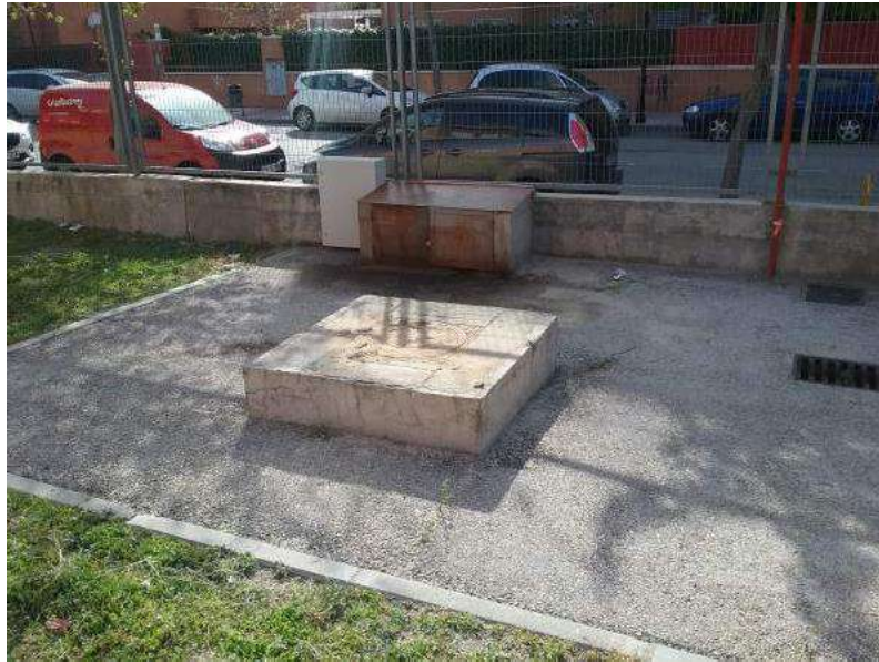
Zona de Recarga y tapa del depósito
